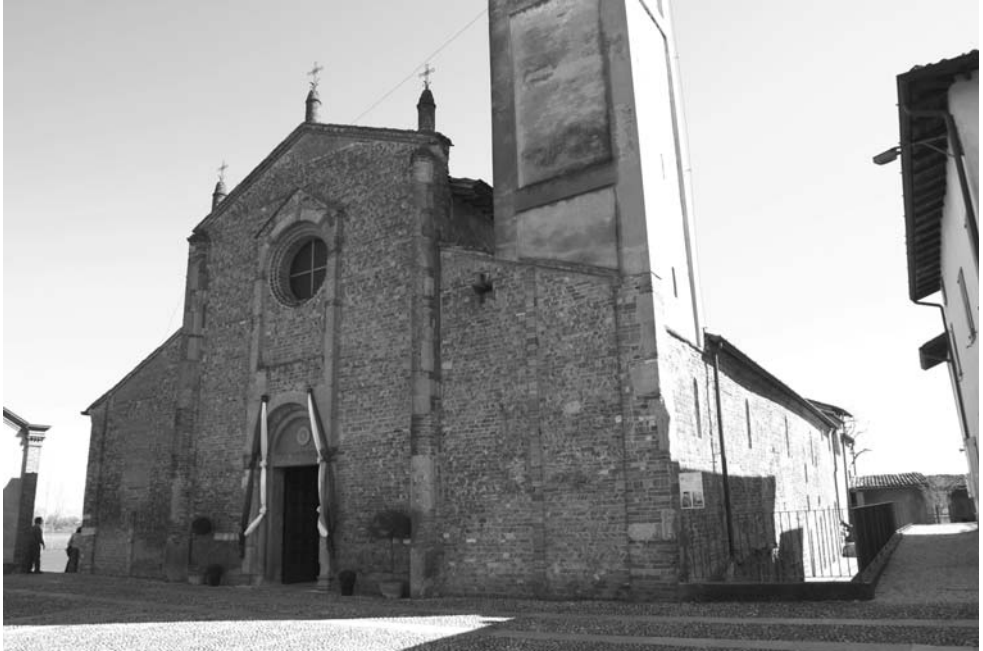
Fig. 2. Palazzo Pignano (Cremona, Lombardy), San Martino, façade.
